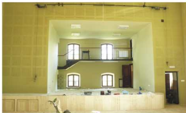
Wnętrze sali widowiskowej - w trakcie trwania prac
