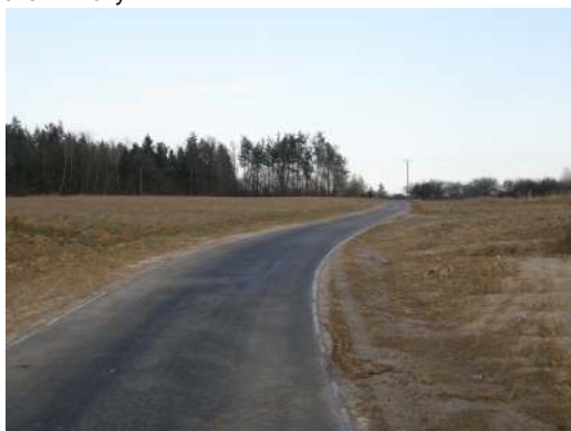
Zmodernizowana droga w Michałówce
